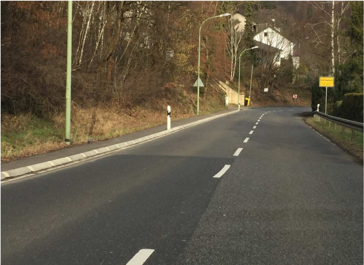
Foto 6: Abfahrt K31 Ortseinfahrt Untermaubach
