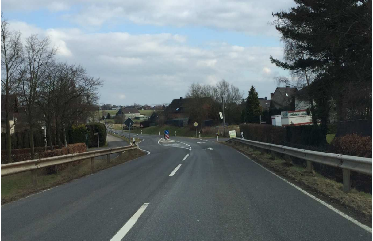
Foto 1: L11 Verkehrsinsel schlecht einsehbar Ortschaft Brandenburg
